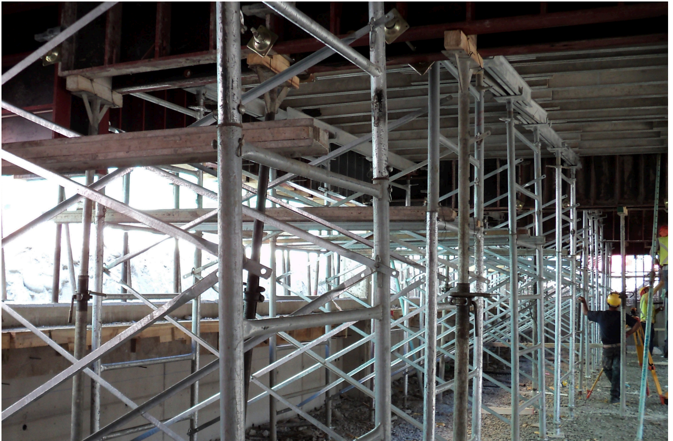
Soporte Losa Hi Load. Edificio Constructores. Las Condes. 2013
