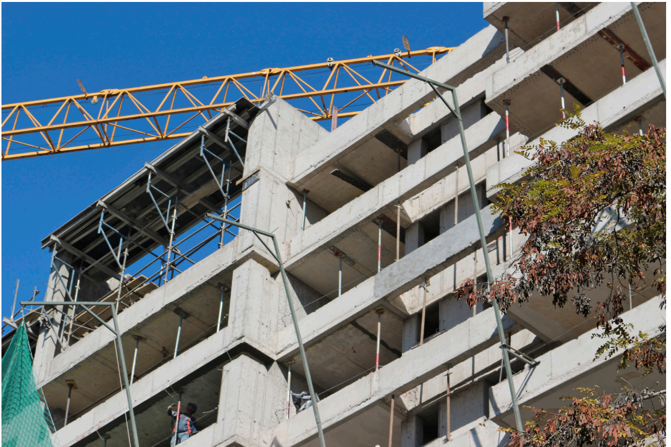
Soporte Losa PT y Encofrado Magnum. Providencia. 2017
