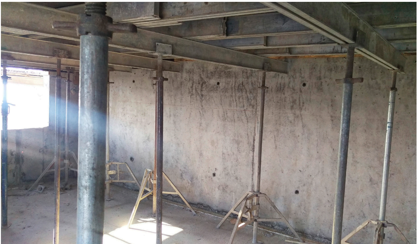
SopORTE Losa Trípede. Edificio en altura. Coquimbo. 2017
