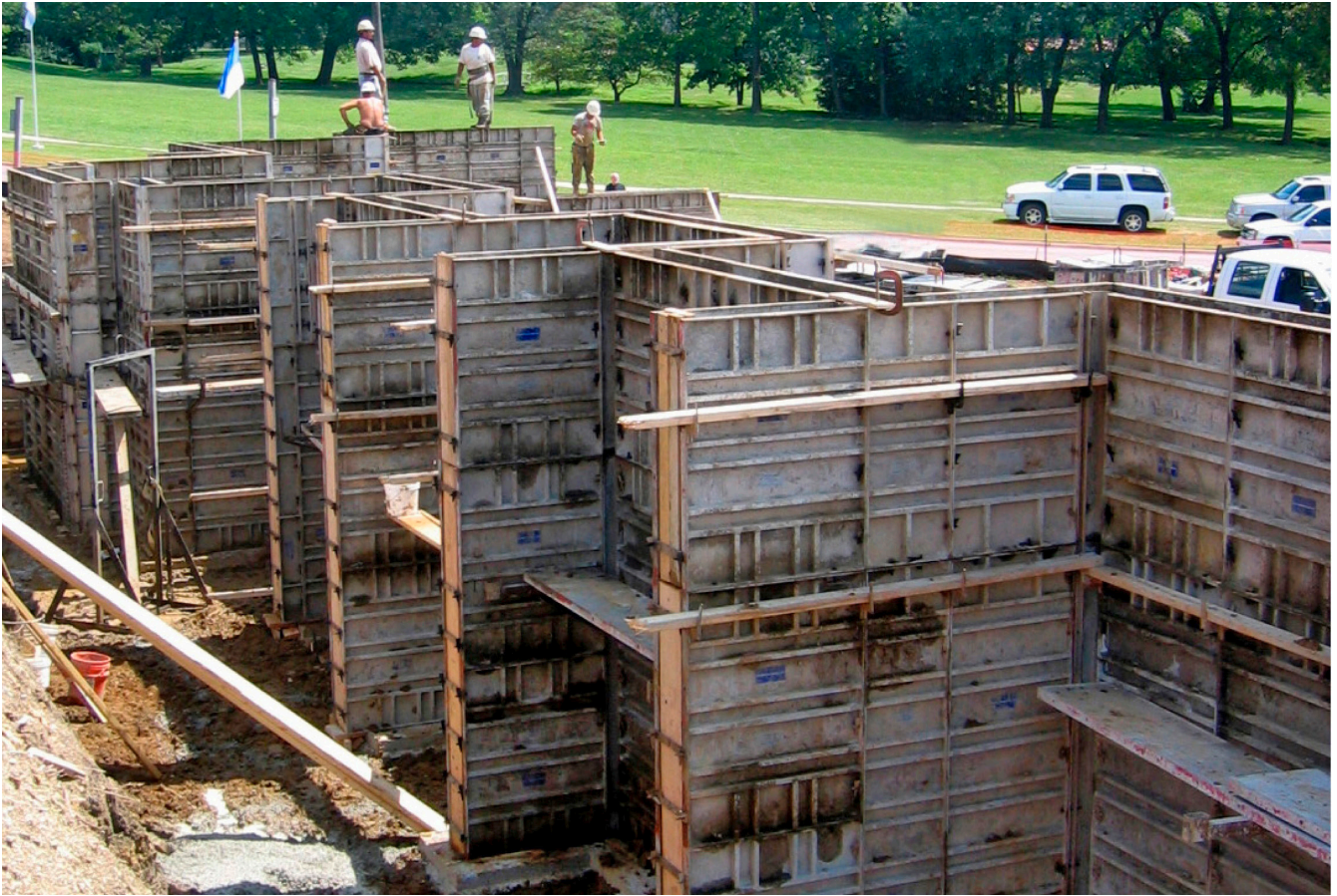
Encofrado de Muros Alulight. Valle Indigo. 2010
