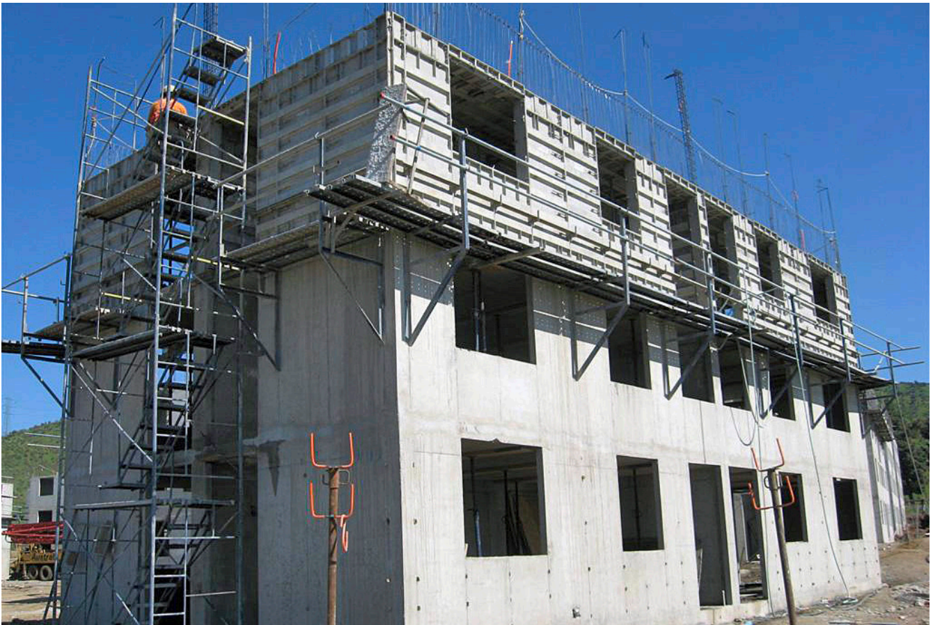
Encofrado Monolítico de Muro y Losa Alulight. La Calera. 2012
