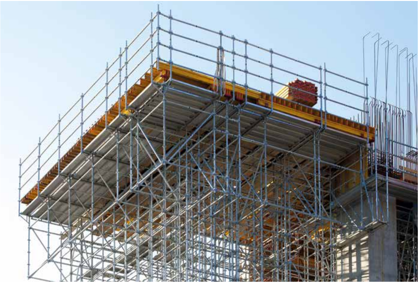
Soporte de Losa con Andamio AMD Multidireccional. 2015
