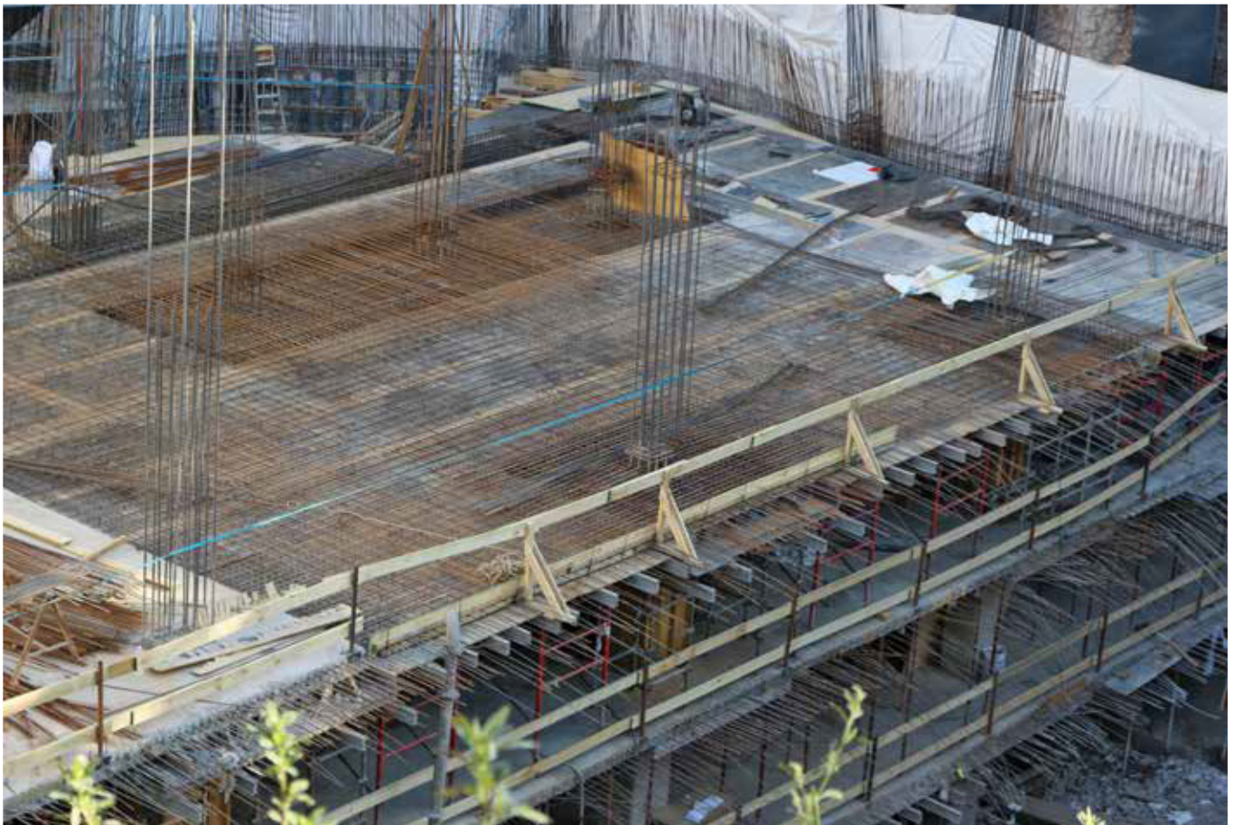
Losa Hi Load Centro Gastronómico Bellavista. Providencia. 2017
