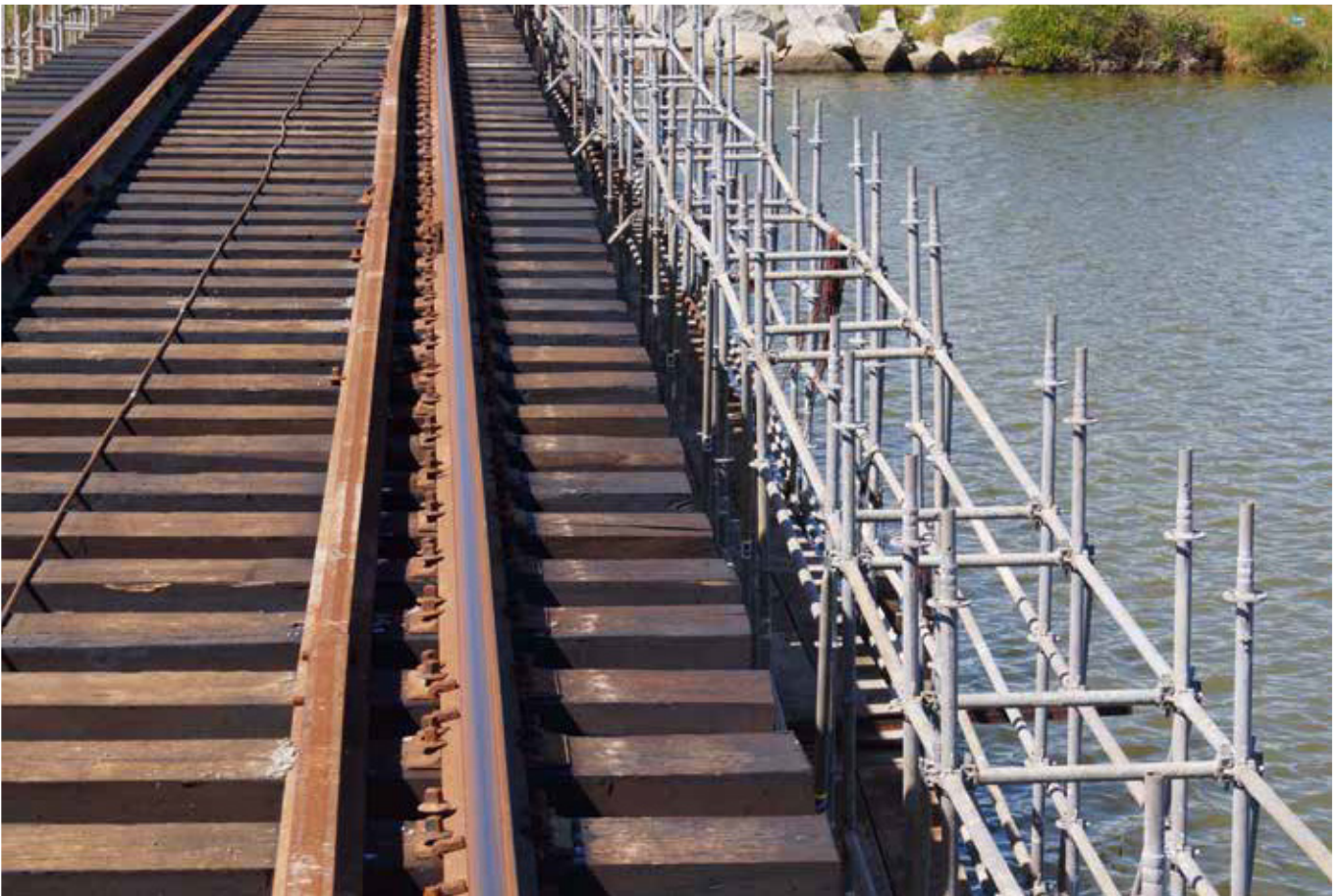
Andamio AMD Multidireccional. Puente ferroviario. 2017
