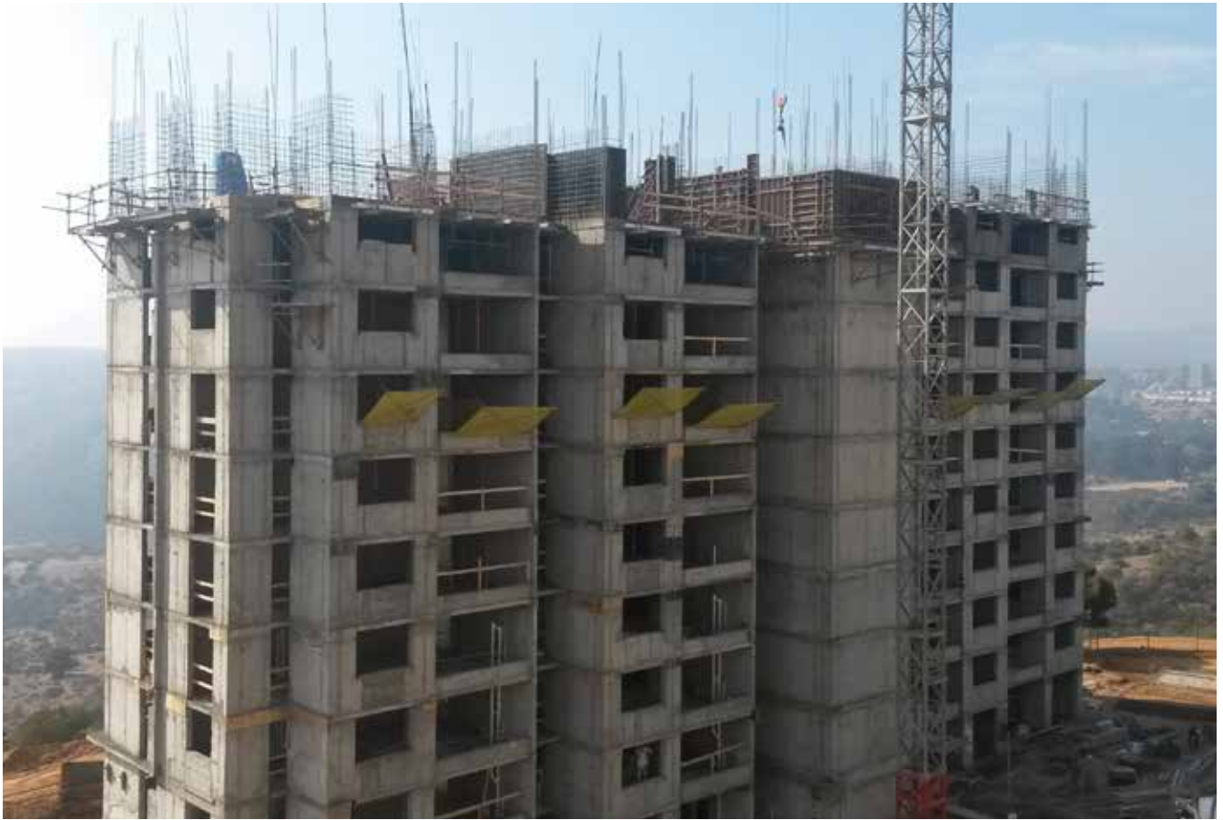
Encofrado Magnum, Soporte de Losa Trípedo. Viña del Mar 2014
