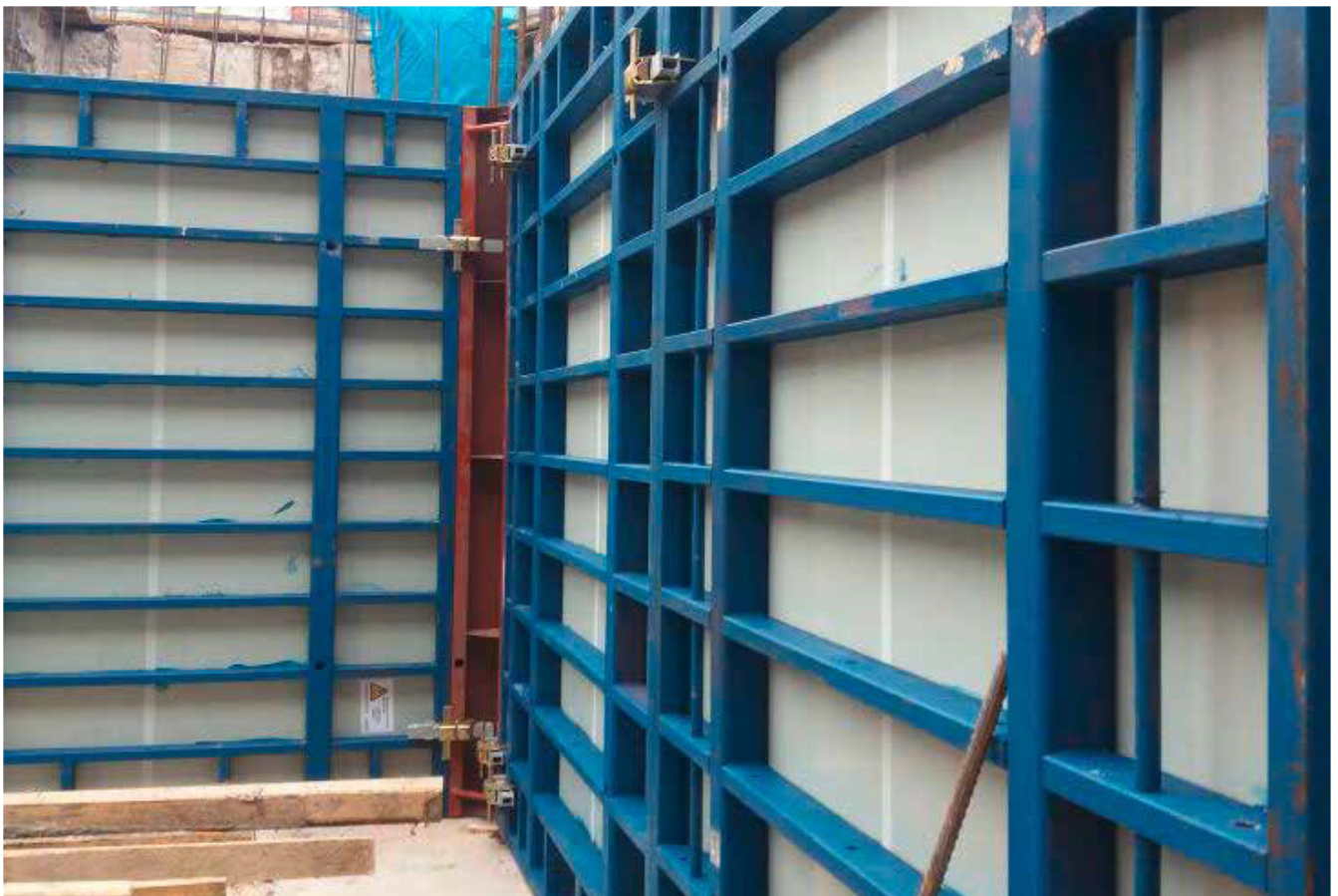
Encofrado Magnum Dos Caras. Maipú, Santiago. 2017
