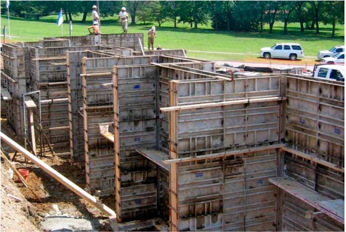
Encofrado de Muros Alulight. Valle Indigo. 2010
