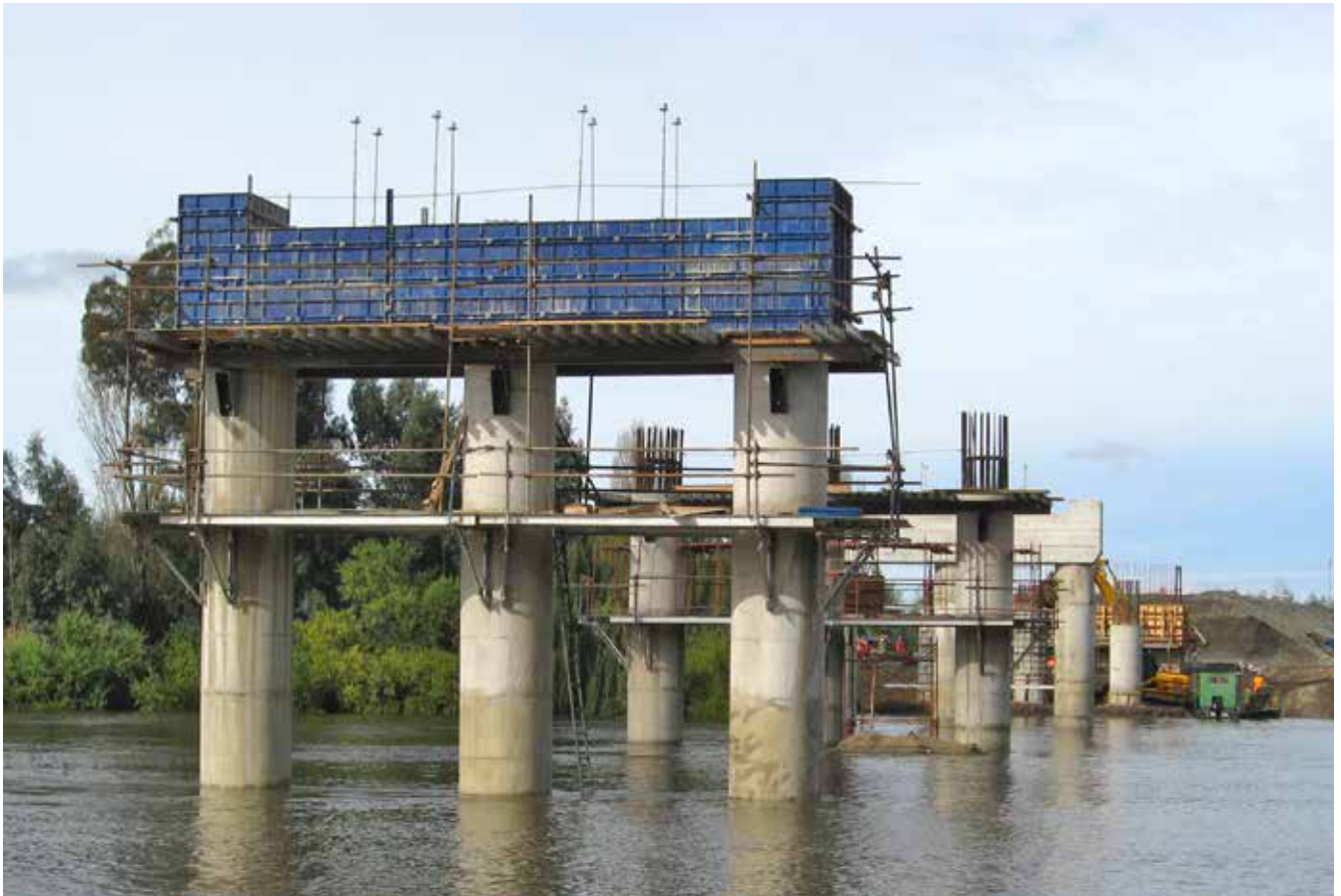
Columnas y Muros dos Caras Allsteel. Bio Bio. 2011
