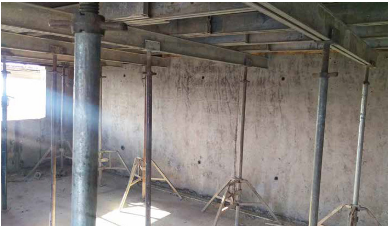
SopORTE Losa Trípede. Edificio en altura. Coquimbo. 2017
